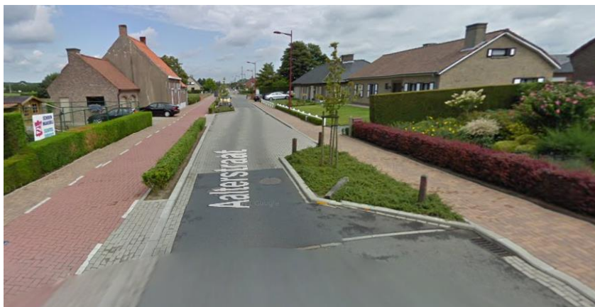
Figuur 4: Voorbeeld van asverschuivingen in Aalterstraat, Ruiselede
